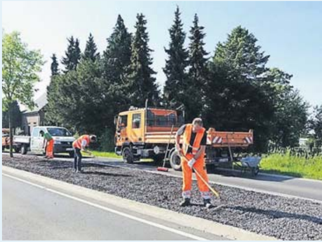
Mitarbeiter des Bauhofes haben in Kempen-Ziegelheide einen speziellen Substrat-Schotter aufgetragen. Foto: Kreis Viersen
